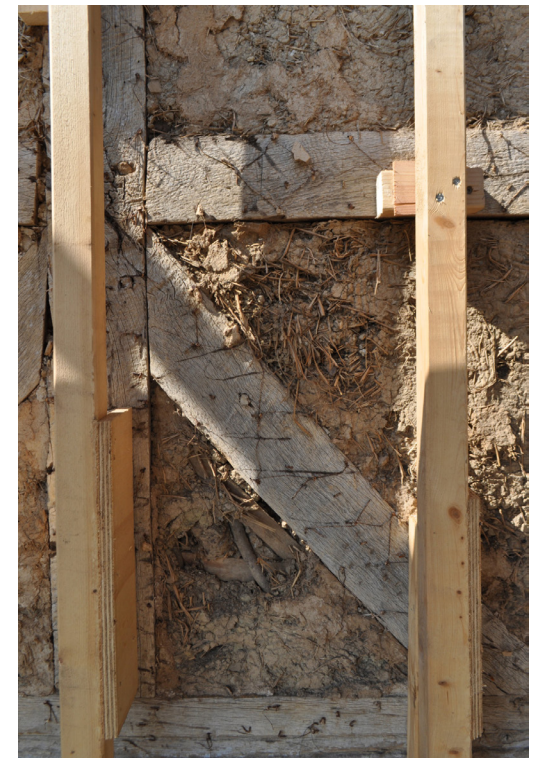
Massivholzmauer-Element (MHM) und Dübelholz
