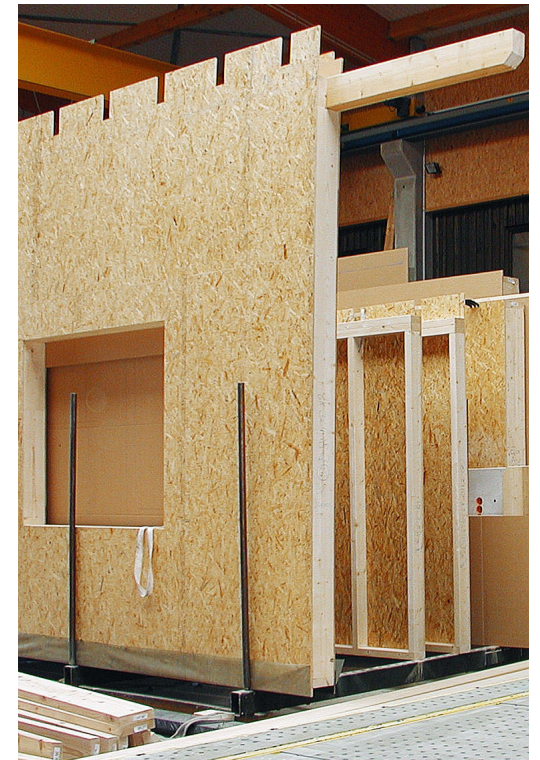
Holzrahmen mit Beplankung aus OSB
