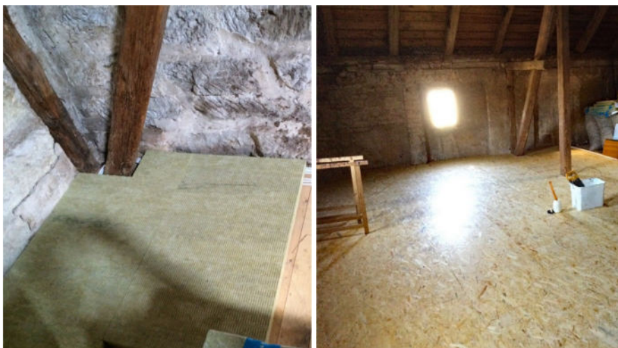
Abbildung 4: links - Mineralwolle-Dämmung; rechts - folgend mit Spanplatten begehbar montiert
