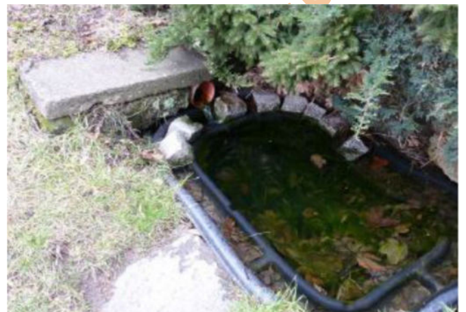
Abbildung 7: Seitengebäude und Quelleinlauf vor dem Abriss des Gebäudes
