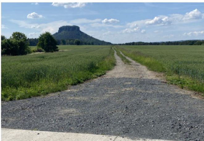
Abbildung 10: Flugplatzweg vor der Entsiegelung (oben) und heute (unten)
