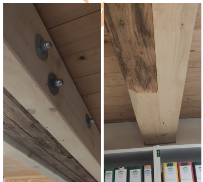
Abbildung 13: Stabilisierte und angeschuhte Balken in den Archivräumen
